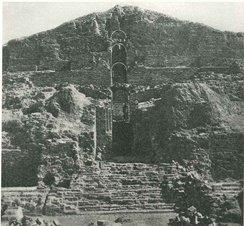
Fig. 28. Zuidwest zijde. De werklieden staan op de drie overlopen, die de trappen met elkaar verbonden. Drie ontbrekende bogen zijn met stippellijnen aangeduid.
