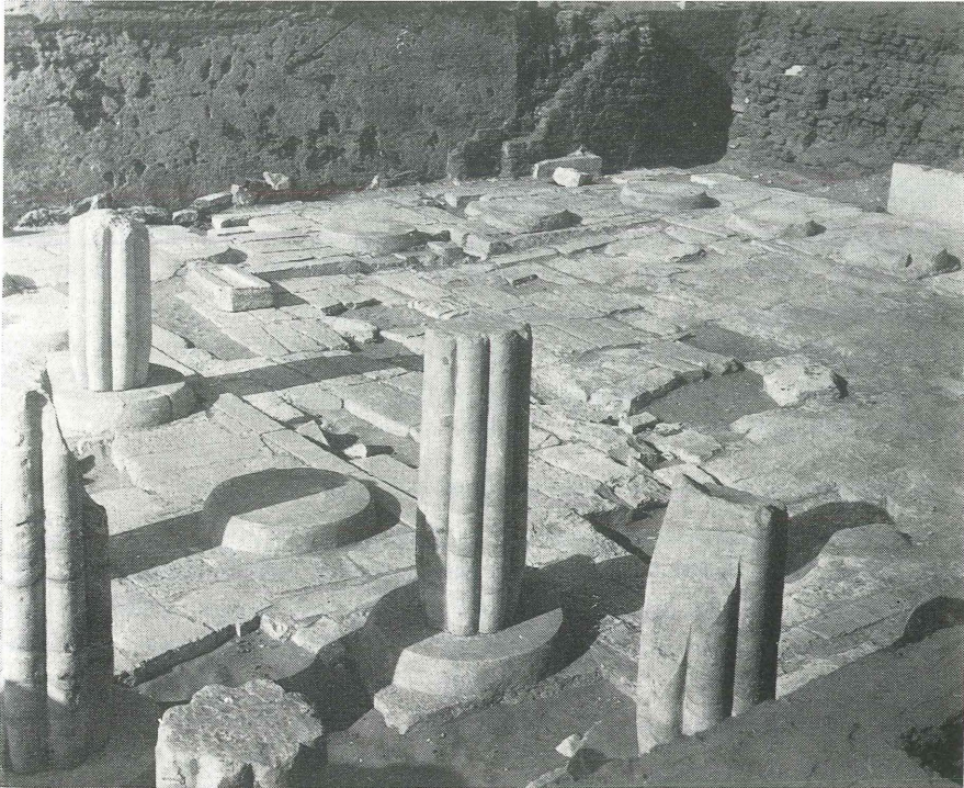
Fig. 6. De Grote Binnenhof met de Noord-wand. Tussen de twee middelste zuilbases, bovenaan, bevindt zich de afvoergoot.
